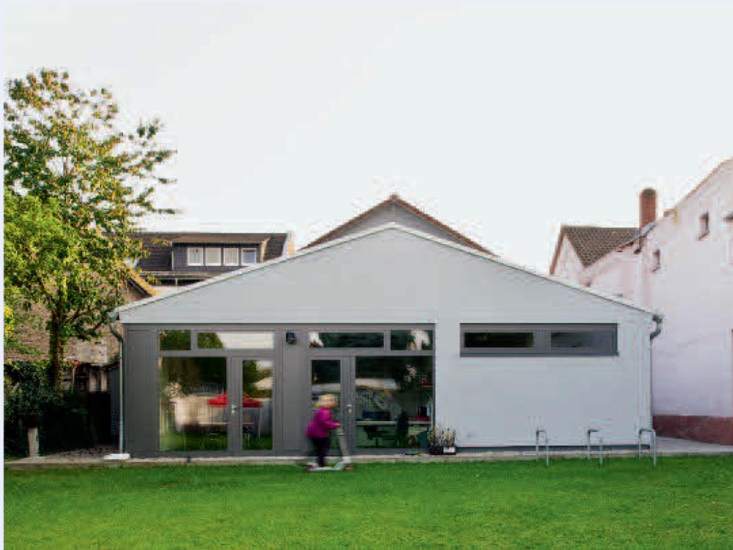
Gruppenraum mit unmittelbarem Zugang zum Garten
