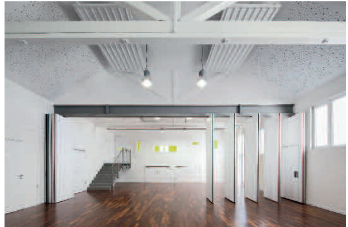
Die Halle ist durch verschiebbare Wandelemente teilbar und damit außerordentlich flexibel nutzbar.
